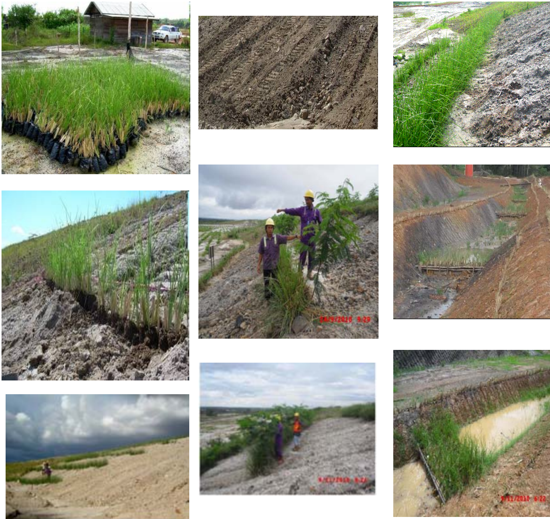
Foto 21: Penerapan sistem vetiver di PT. Adaro, Kalimantan (Foto credit: Presto J. Saputra)
