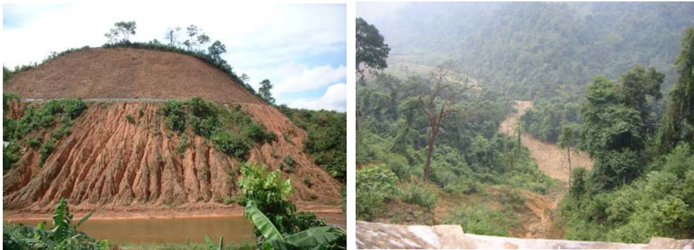
Foto 20: Kiri: pembuangan sampah batu/tanah yang tidak benar bergerak jauh ke hilir; kanan: memberi dampak untuk desa di wilayah A Luoi, propinsi Thua Tien Hue
