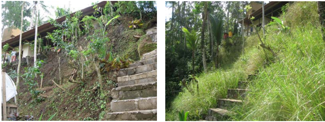
Foto 19: VS menstabilkan lereng 70 derajat vila untuk menghentikan erosi dan tanah longsor. Kiri: Sebelum penanaman vetiver. Kanan: 4 bulan setelah tanam.
