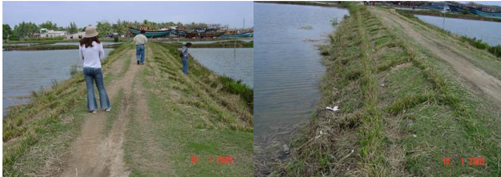
Foto 24: Vetiver, ditanam dengan bentuk bersilang, melindungi tanggul pematang tambak ikan di Quang Ngai
