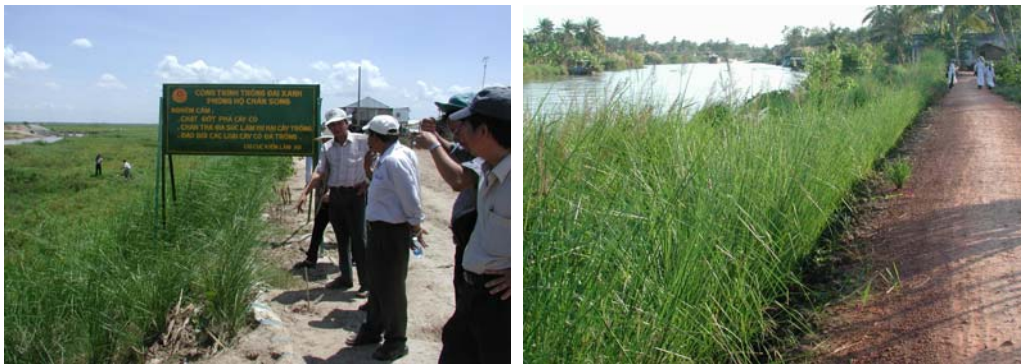
Foto 15: Di An Giang Vetiver menstabilkan tanggul sungai (kiri), dan tepian sungai alami (kanan)
