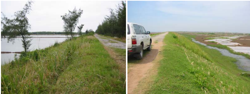
Foto 18: Di Vietnam utara; kiri: Vetiver ditanam di bagian luar tanggul laut yang baru dibangun di propinsi Nam Dinh; kanan: disisi dalam tanggul, ditanam oleh Departemen Tanggul lokal
