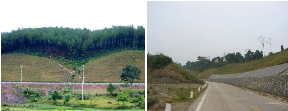
Foto 19: Kiri: Vetiver menstabilkan lereng akibat kerukan sepanjang jalan raya Ho Chi Minh; kanan: Vetiver baik sendiri maupun dikombinasikan dengan cara tradisional
