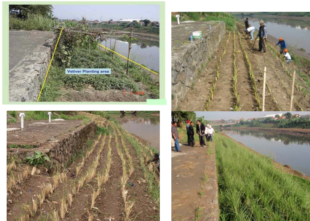
Foto 13: Kiri atas: Tanki Septik di atas tepi sungai sebelum VS; Kanan atas: Menanam 40,000 slip vetiver. Kiri bawah: 3 minggu setelah penanaman. Kanan bawah: Vetiver tumbuh sempurna 3 bulan setelah penanaman – telah menyerap limbah tanki septik.
