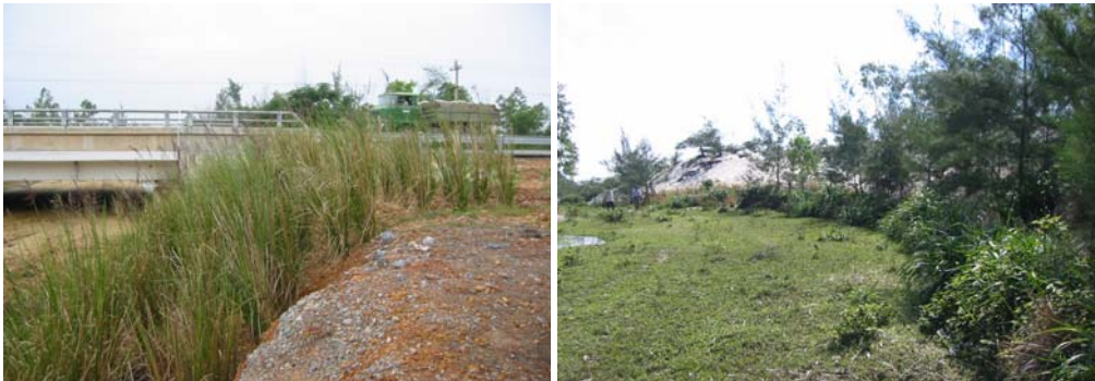
Foto 6: Kiri: Vetiver melindungi penopang jembatan sepanjang Nat. Highway nr.1; kanan: Desember 2001, spesies lokal telah menggantikan Vetiver.
