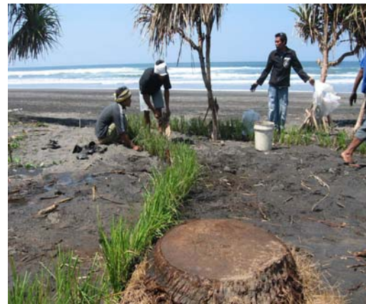
Photo 15: Villa di pantai Ketewel: Akar vetiver yang cepat tumbuh masih tetap berkembang setelah erosi penuh, akar vetiver secara vertical menopang pasir
