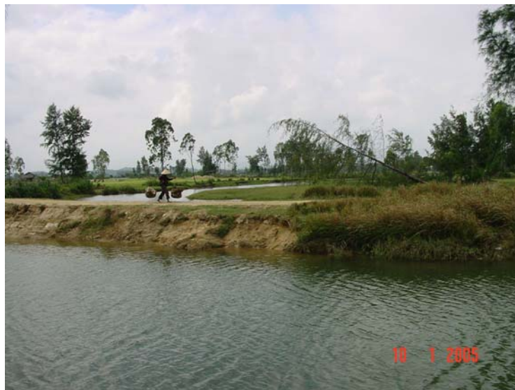
Foto 24: Vetiver, ditanam dengan bentuk bersilang, melindungi tanggul pematang tambak ikan di Quang Ngai
