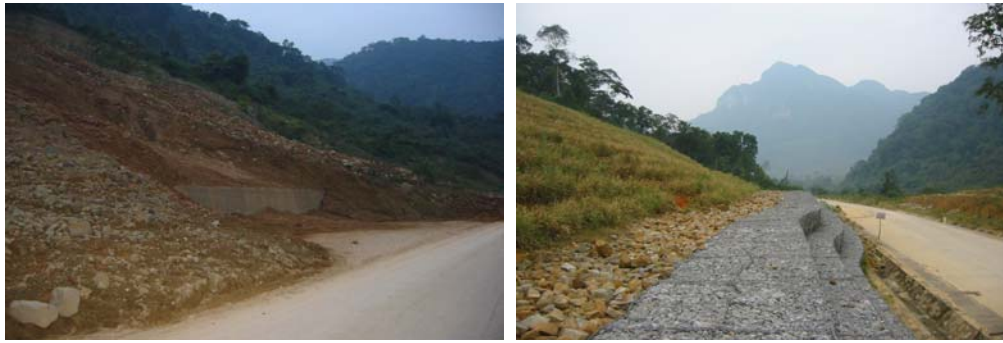
Foto 21: Da Deo Pass, Quang Binh: Kiri: Vegetasi penutup yang hancur, menunjukkan hasil buruk dan longsor lereng buatan yang terus menerus; kanan: Baris Vetiver di lereng paling atas secara perlahan menekan ke bawah dan cukup banyak mengurangi longsor yang besar
